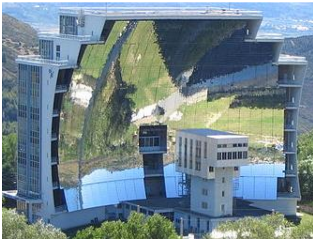
Das Centre du Four Solaire Félix Trombe in Odeillo, Frankreich, fokussiert von vielen Spiegeln reflektiertes Sonnenlicht. Foto: Björn Appel, Quelle: wikimedia.org
